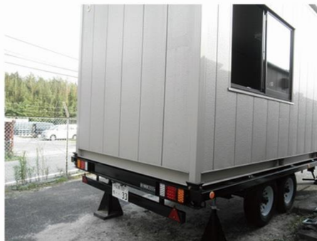
写真2.営業所としての設置状況
